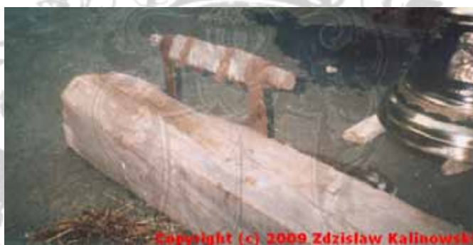
Wycięta z dzwonnicy dębowa belka z zachowanym uchwytem, na, którym wisiał niewielki dzwon w latach 1940-1945. Przykuwa uwagę prymitywizm konstrukcyjny i jego niewielka wytrzymałość.
