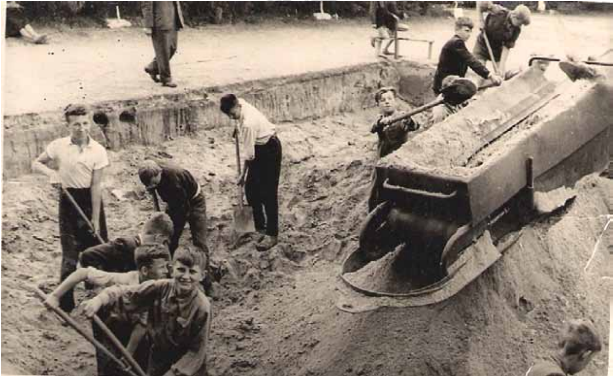
Etapy stanu prac budowlanych.
