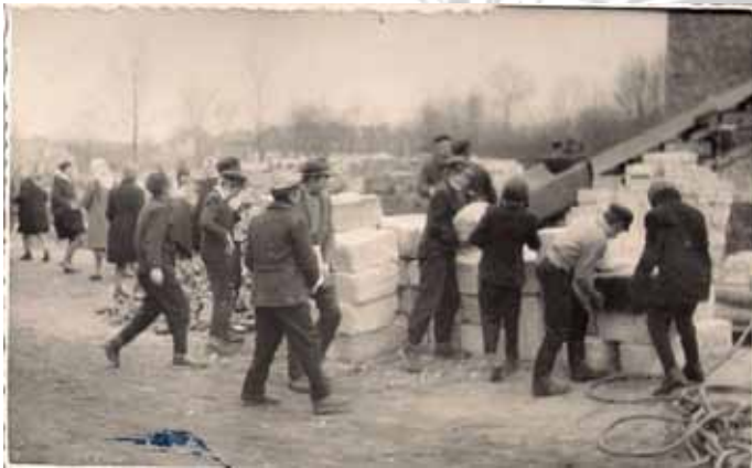
Transport materiałów budowlanych na miejsce pracy murarzy.
