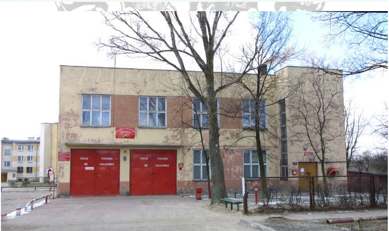
.Remiza strażacka w Rejowcu.
