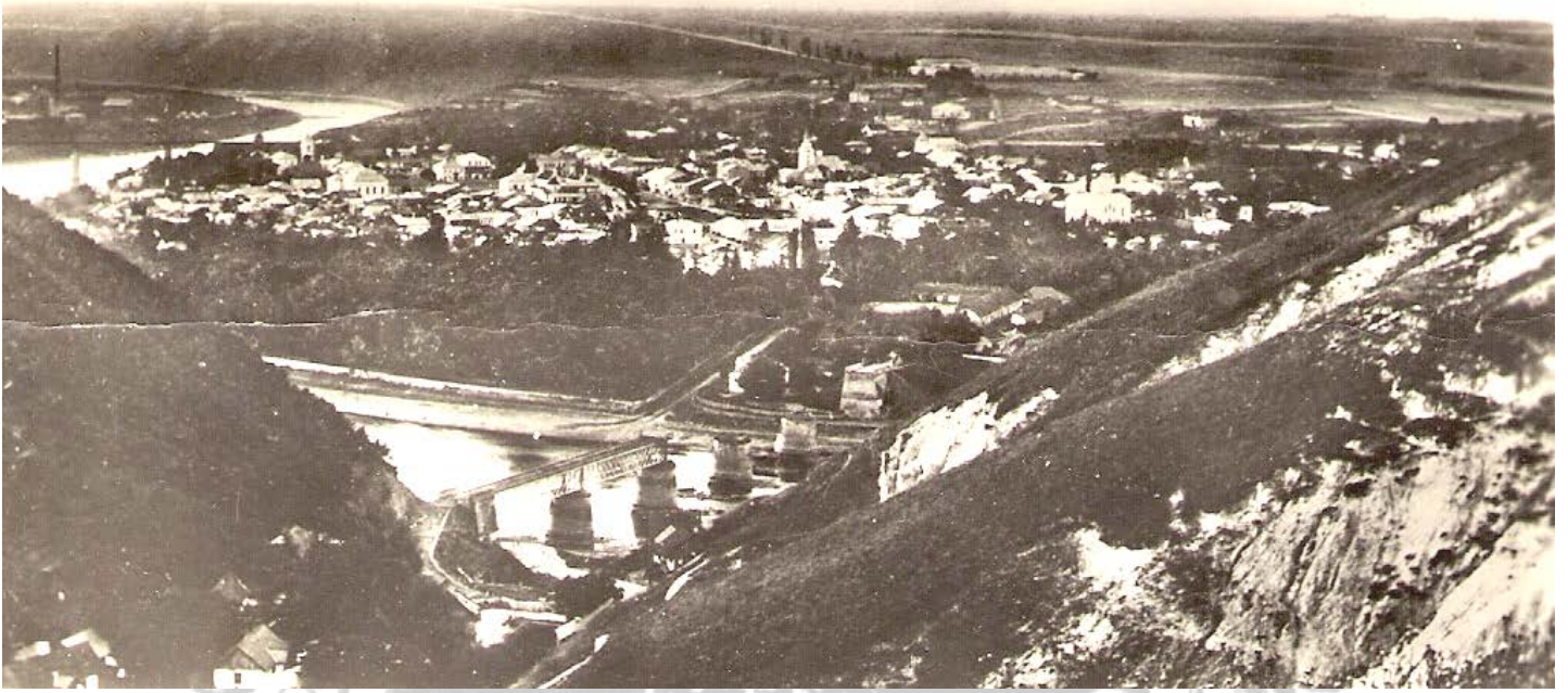
Spojrzenie na Zaleszczyki i przeprawę mostową w zakolu rzeki Dniestr.
