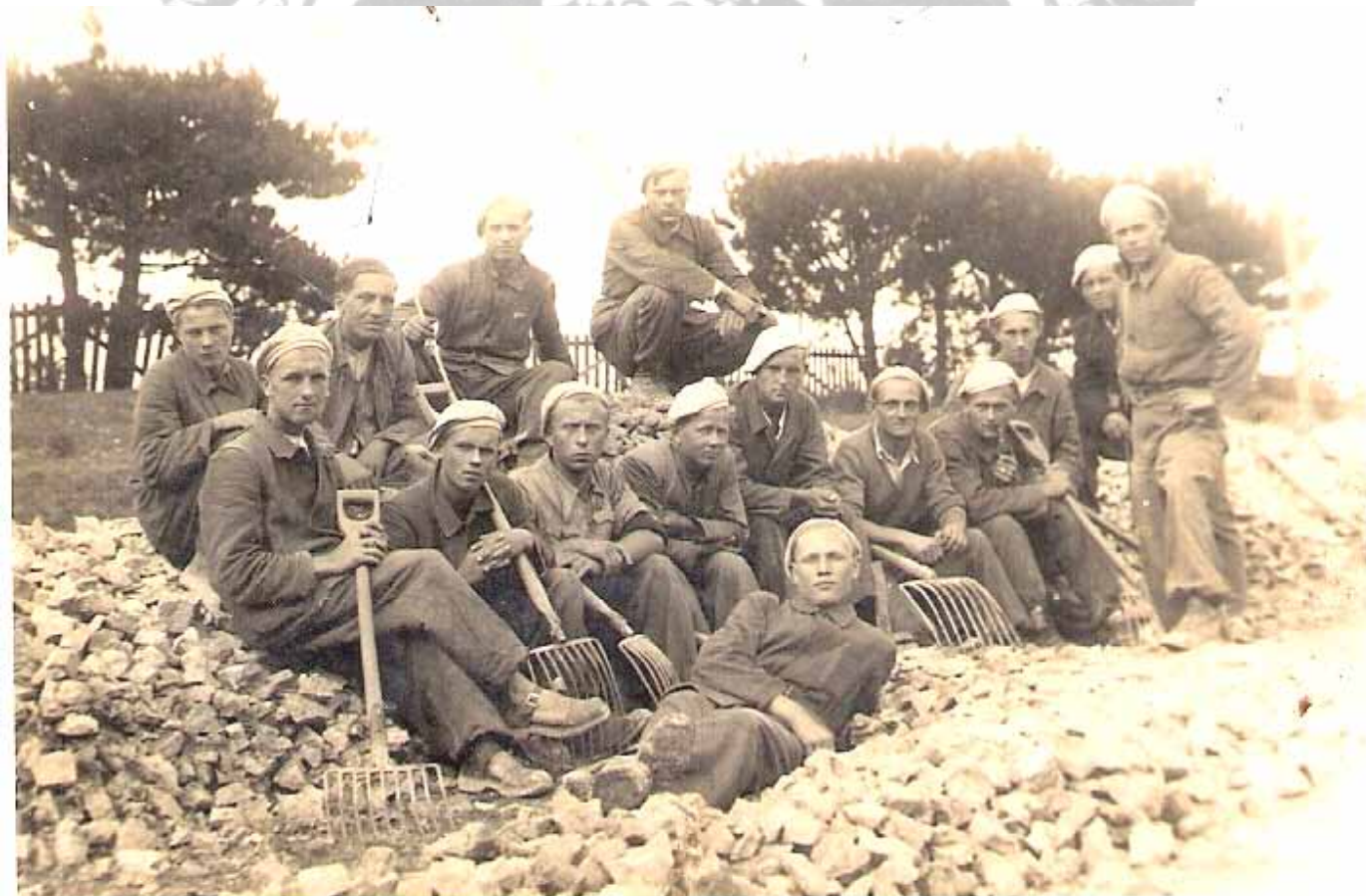
Krótki odpoczynek w czasie prac przy odbudowie torowiska (uzupełnianie podsypki) i torów kolejowych po wysadzeniu przez minerów „Rębacza” w okolicy Adamowa gm. Rejowiec.
