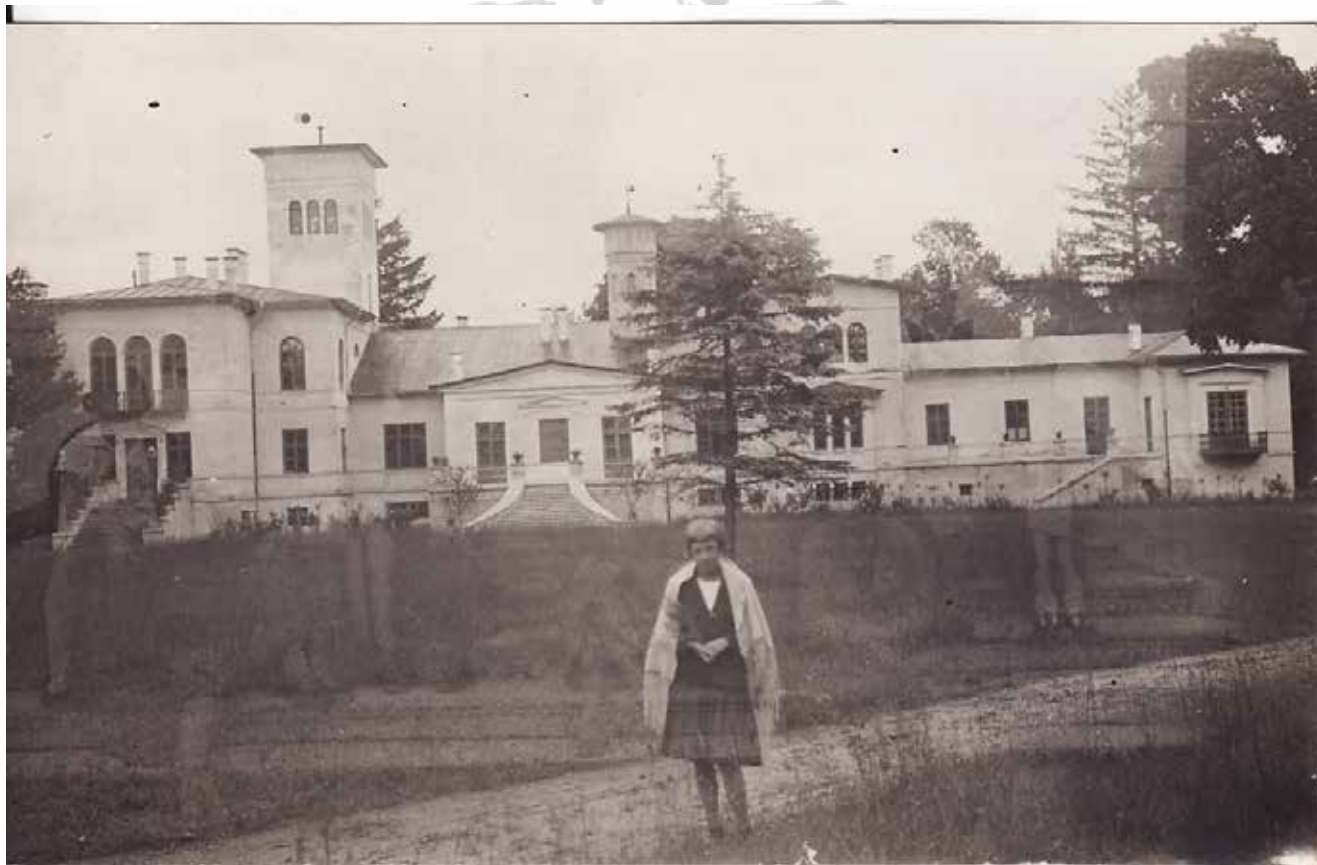
Dwór w Świerżach (Pałac murowany)-
